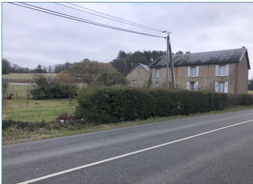
Ancien corps de ferme, le long de la D914
