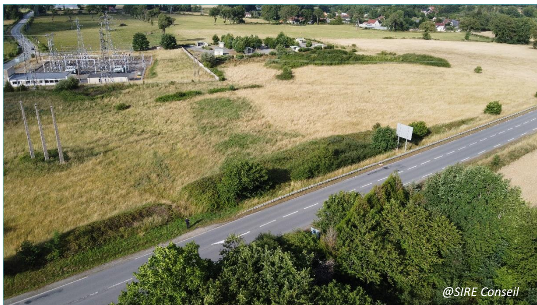
Vue de drone sur la partie Nord du secteur et sur la RD100
