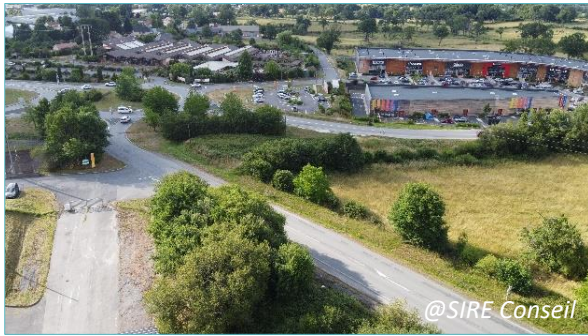
Vue de drone vers l'Ouest : rond-point du Colonel Fabien et zone commerciale du Corbigny
