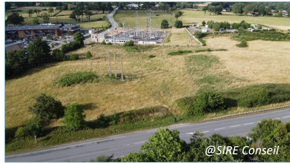
Vue de drone sur la partie Nord du secteur, la centrale électrique et l'Aire d'Accueil des Gens du Voyage
