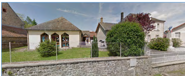
Vue sur l'école depuis la rue des Ecoles
