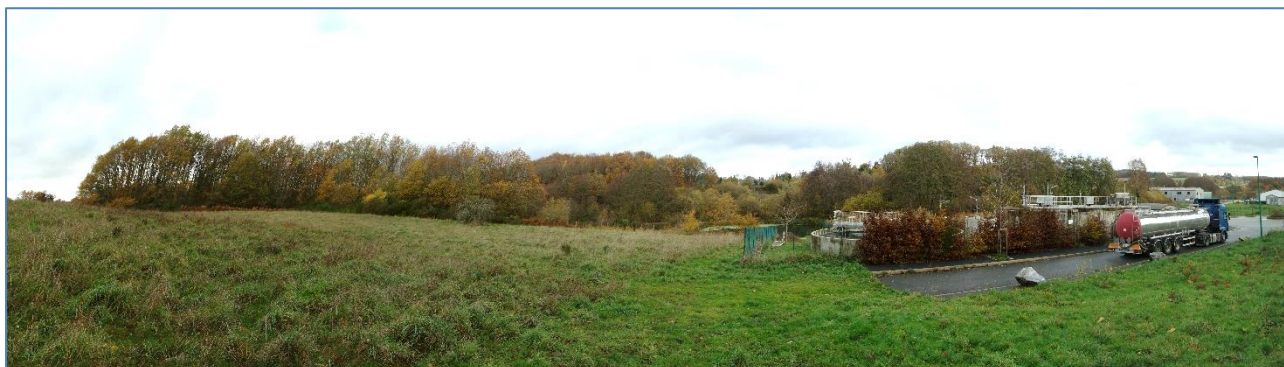
Vue sur le site depuis le Sud de la zone
