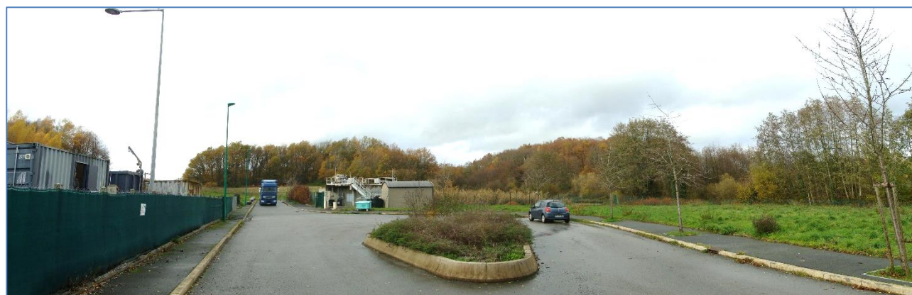
Vue sur le site et sur l'amorce de voirie existante (à gauche) depuis l'aire de retournement interne à la zone d'activité de la Jarrige
