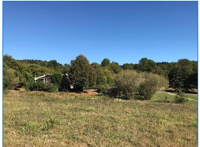
Vue d’une partie de l’ensemble bâti depuis la route
